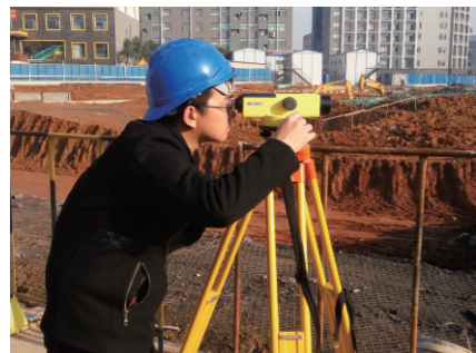
房屋建筑施工测量
